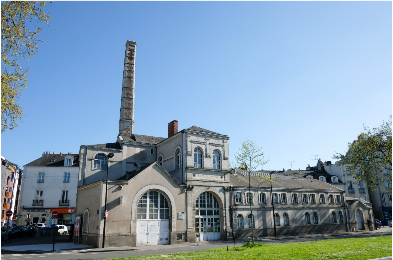
Les bains-lavoirs allée Baco
